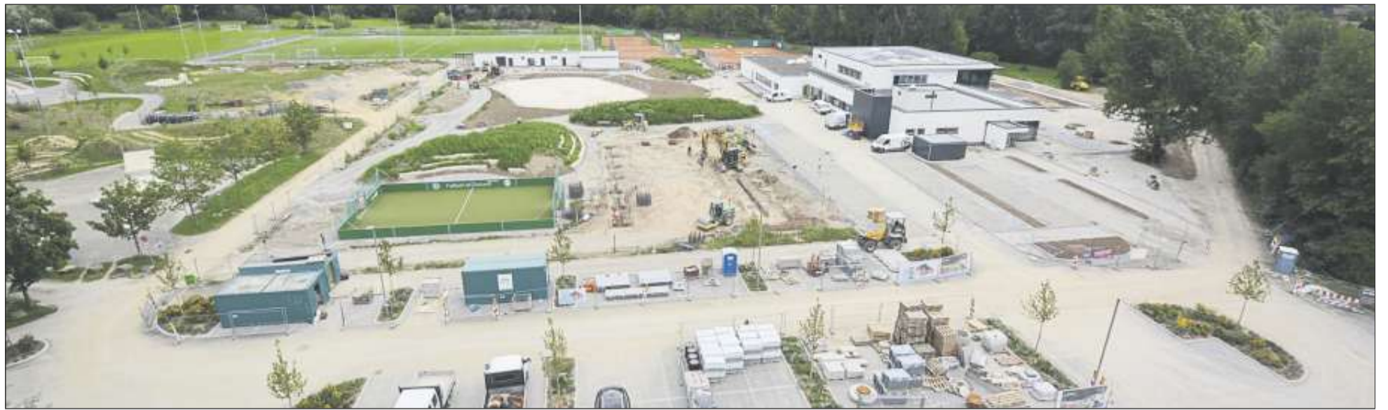
Ein Blick von oben auf den Sportpark Rems in dieser Woche. Die Bauarbeiten schreiten voran.
