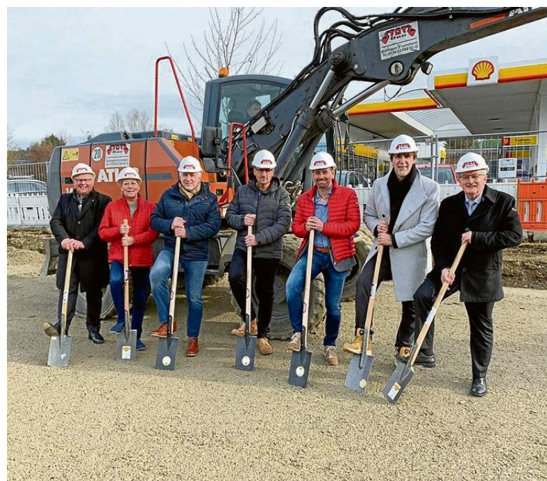
Der Spatenstich im Januar.
