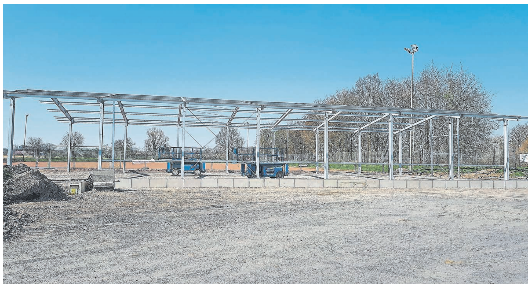
Das imposante Stahlgerüst lässt erahnen, welche Ausmaßnahme die EK-Arena auf dem Sportplatz der DJK Rödder künftig haben wird.
